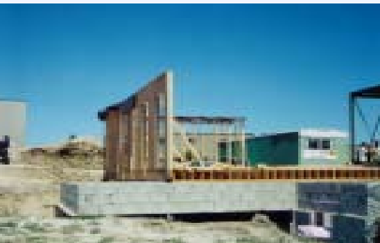
ဇူလိုင်လ ၂၅ ရက်နေ့ကျောင်းတည်ဆောက်ပြီးမြင်ကွင်း
