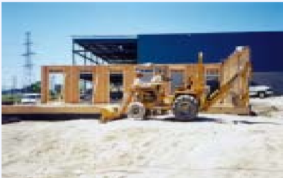
ဇူလိုင်လ ၃၁ ရက်နေ့ကျောင်းတည်ဆောက်ပြီးမြင်ကွင်း
